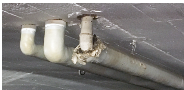
Réparer les isolations abîmées.
